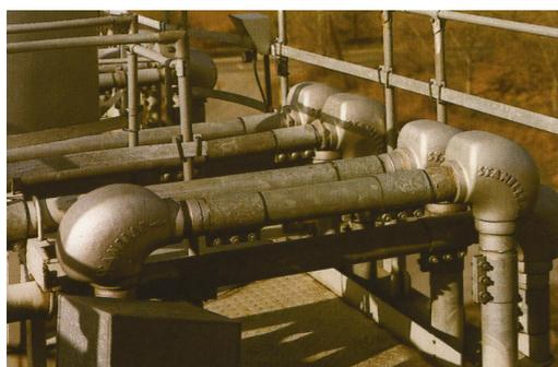
Der FLOW-BOW® dient zur verschleißarmen Umlenkung von trockenen, nicht klumpenden Schüttgütern, bei der Dichtstromförderung. Sein Einsatzbereich ist vielseitig und reicht von pulverförmigen, splittigen bis hochabrasiven Schüttgütern, wie z.B. Quarzsand, Spritzbeton, Basaltsplitt, bis zu Kakao-Schalen oder Einsatzfällen bei der Tierkörperverwertung. Für den Einsatz in der Kunststoff- und Lebensmittelindustrie stehen Ausführungen in Edelstahlguss (1.4408) zur Verfügung.
